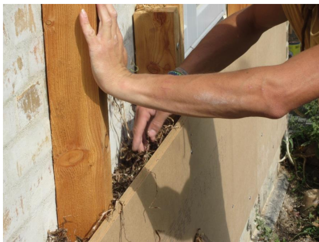
Abb. 5: Nachträgliche Fassadendämmung: Holzfaserplatte und Seegras. Später kann so eine Fassade mit Lärchenholz verschalt werden; zwischen Verschalung und Dämmung bleibt ein Luftspalt als Hinterlüftung. Es ist auch möglich – bei einem etwas anderen Aufbau - so eine Fassade zu verputzen. (Foto: Jan Dobbemann)
