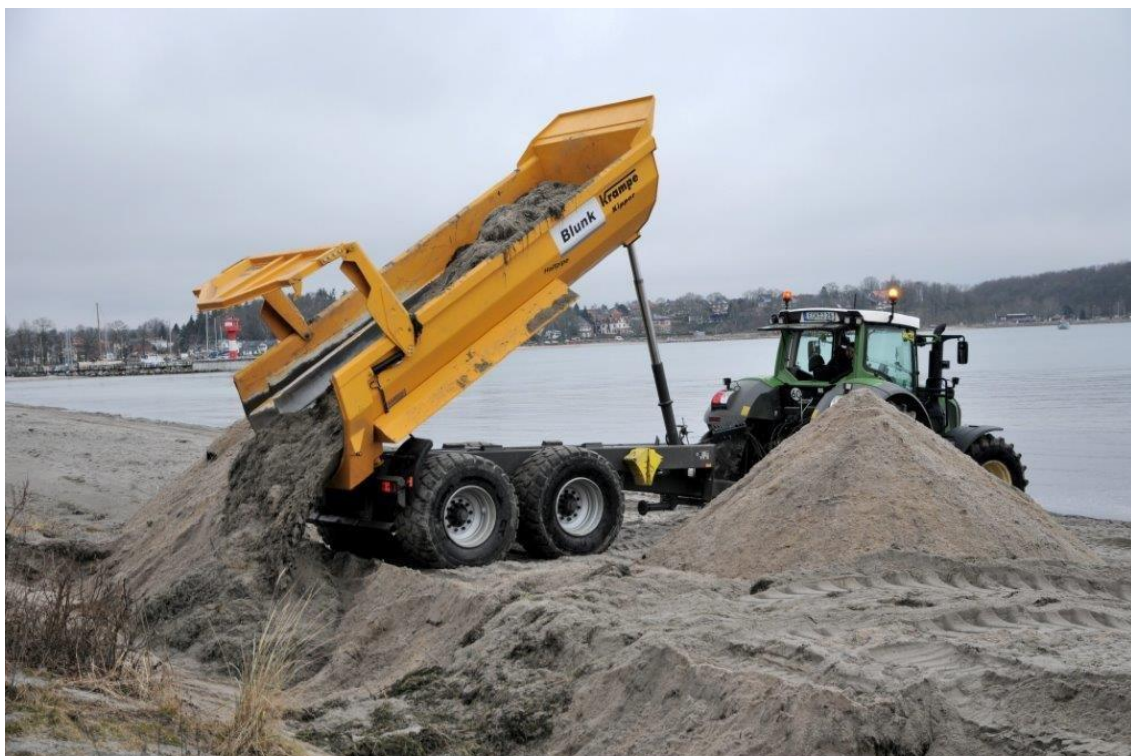
Abb. 6: Der Graben wird mit Seegrass verfüllt und anschließend mit dem ausgehobenen Sand überdeckt. (Foto: Michael Packschies)
