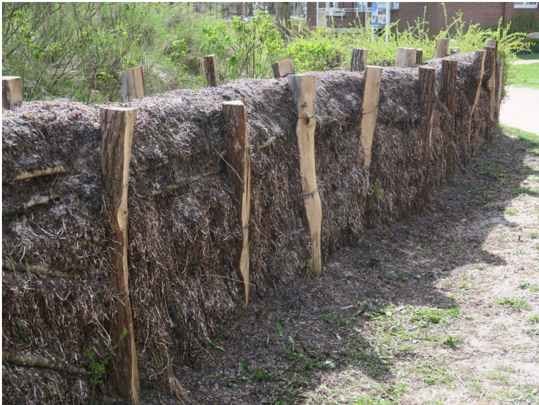
Abb. 11: Faschinenähnlicher Seegrassaun als Sandfang zwischen Strand und Promenade im April 2019 (Foto: Michael Packschies)
