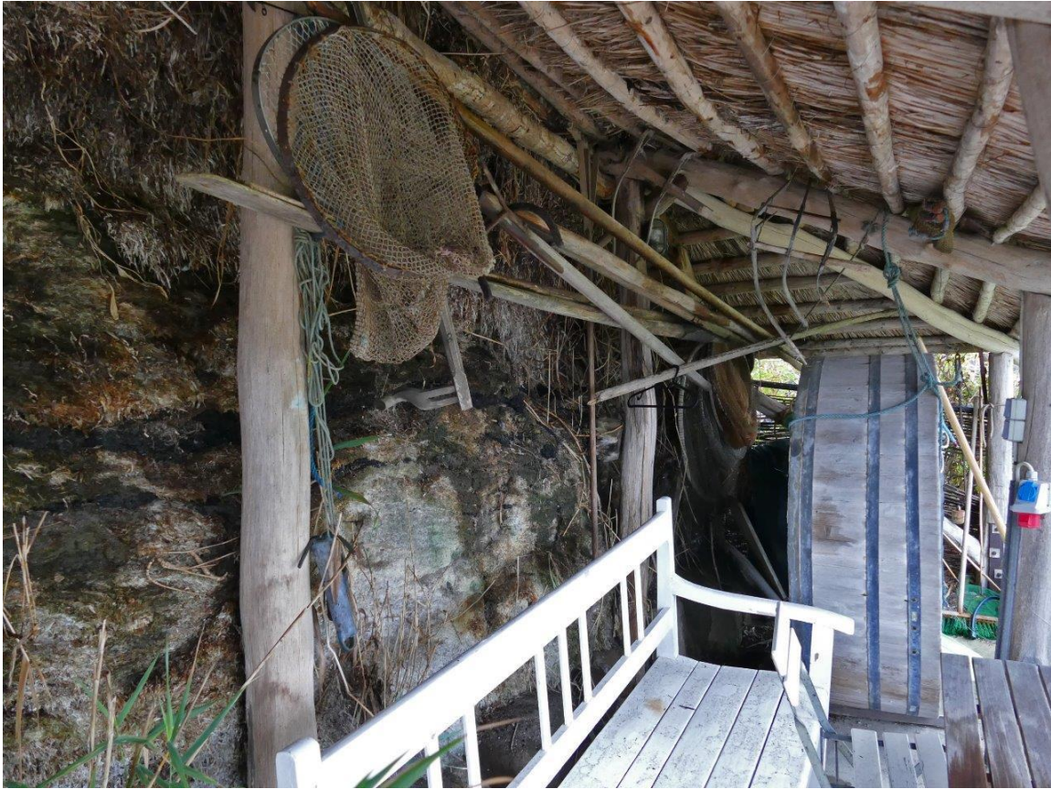
Abb. 10: Blick in den reetgedeckten Unterstand, der Bestandteil des Tangdige Fiskop/Fyn ist. Links sind die geschichteten Seegraslagen zu erkennen, die vor der Brandung schützen (Foto: Michael Packschies)
