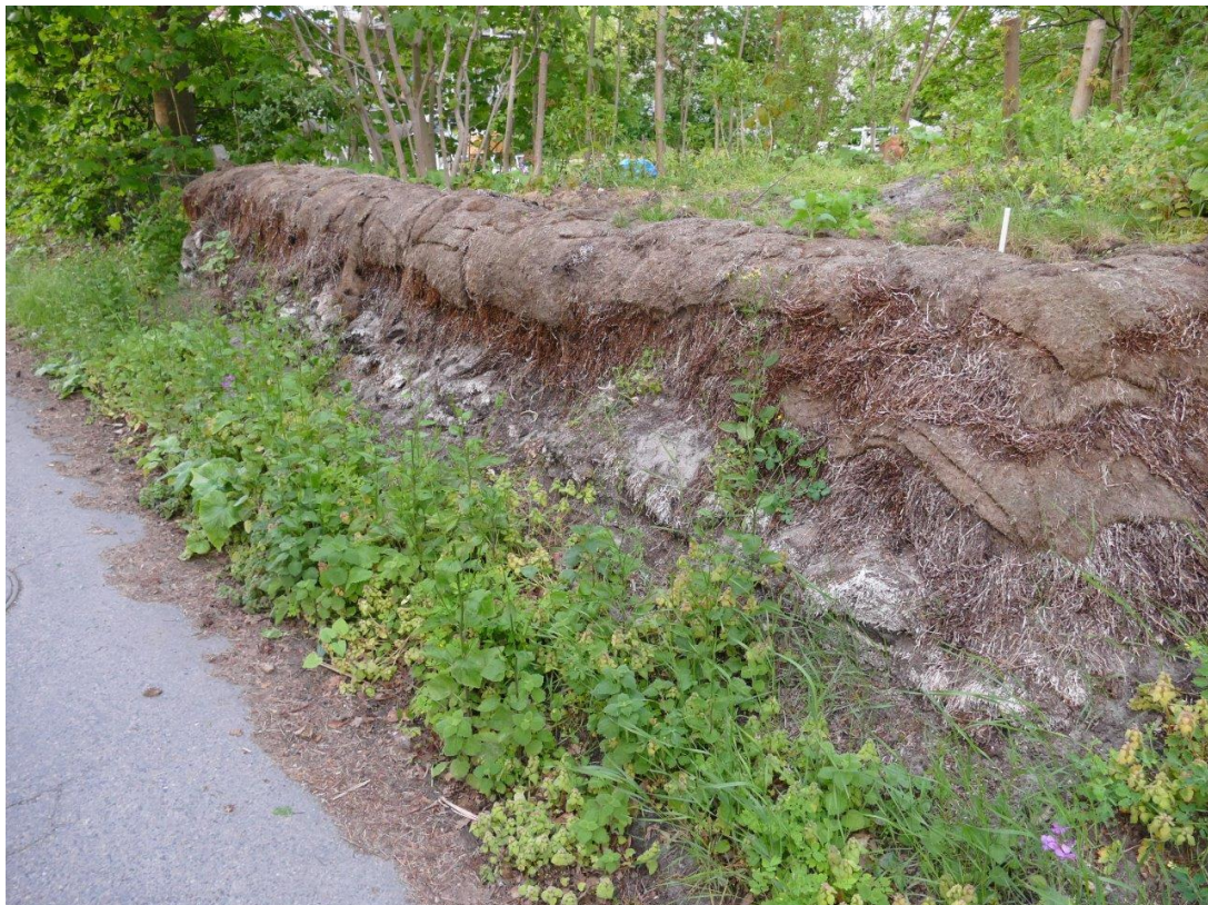
Abb. 5: Fachgerecht restaurierter Abschnitt des Tangvalls von Falsterbo, Strandbadsvägen/Vallbovägen (Foto: Michael Packschies)
